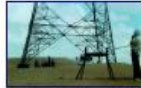
Inspección e instalación Página 18
